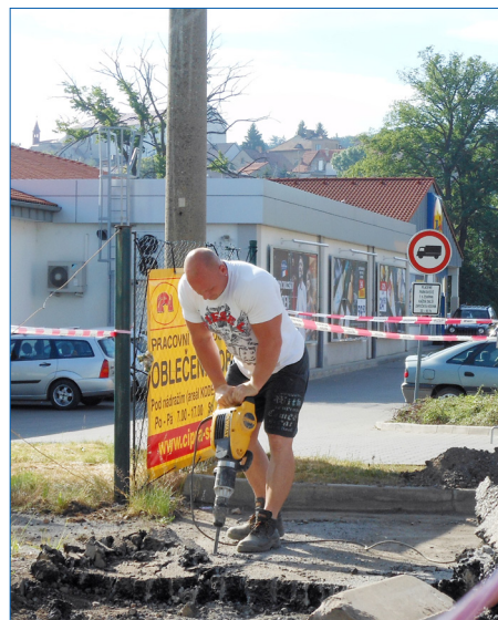
■ Ve Fügnerově ulici vzniká nové parkoviště i chodník. Foto: (rak)
