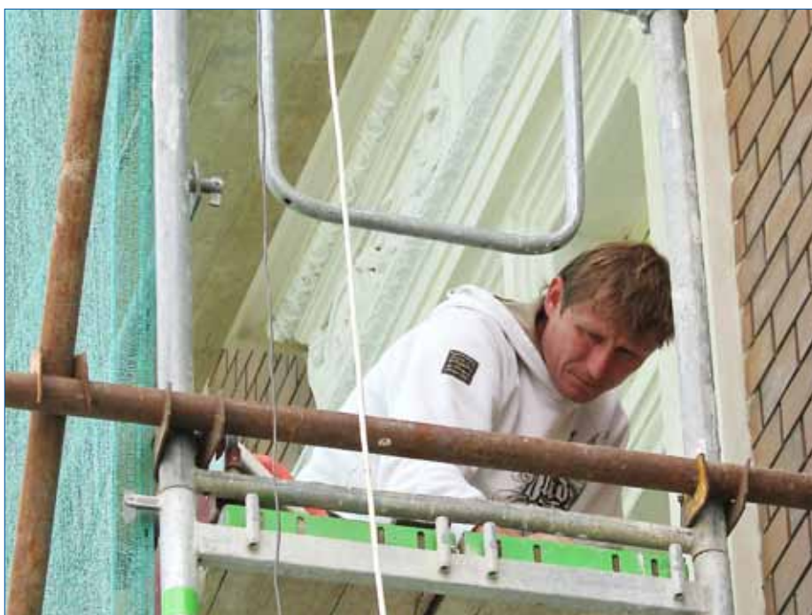
■ Přívalové deště poškodily fasádu radnice, opravu podpořila dotace. Foto: Radka Kočová
