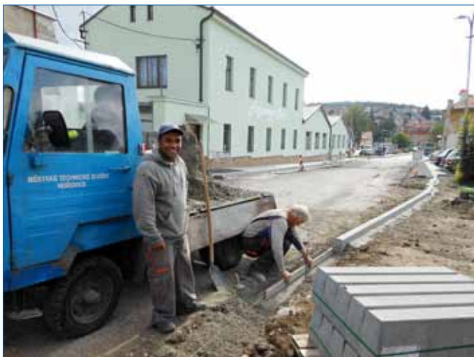
■ Pracovníci Technických služeb města Hořovice dokončují úpravy parkoviště ve Fügnerově ulici. Foto: Radka Kočová
