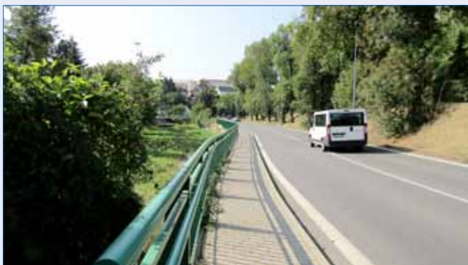
■ Výbudování nových chodníků v Tyršově (foto vlevo nahoře) ulici a Příbramské (foto vpravo nahoře) přispělo k bezpečnosti chodců a větším ohledům ke „slabším účastníkům silničního provozu“, což je nosným programem vedení radnice i do dalších let. Chodník v Tyršově (foto vlevo dole) je částečně vynešen na konzolách nad řečištěm Červeného potoka.
