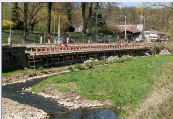
■ Výbudování nových chodníků v Tyršově (foto vlevo nahoře) ulici a Příbramské (foto vpravo nahoře) přispělo k bezpečnosti chodců a větším ohledům ke „slabším účastníkům silničního provozu“, což je nosným programem vedení radnice i do dalších let. Chodník v Tyršově (foto vlevo dole) je částečně vynešen na konzolách nad řečištěm Červeného potoka.
