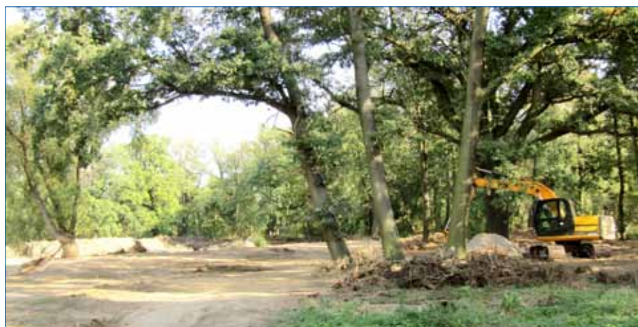
■ Rekonstrukce rybníku Valcverek. 3x foto: (rak)
