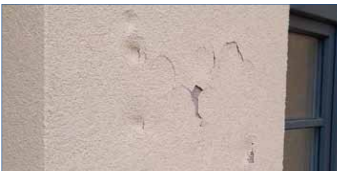
■ Nově zrekonstruovaný hořovický Společenský dům poničili vandalové. Neznámý pachatel prokopl venkovní plášť. Foto: Jiří Hasman
