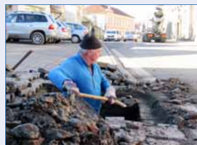
■ Spolehlivý brigádník Jiří Měchura opravuje spadlé části chodníku po opětovném usazení poklopu revizní šachty kanalizace u prodejny domácích potřeb. Závadu způsobil nákladní automobil, který na revizní šachtu v chodníku najel.
