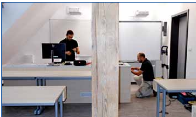
■ Pět nových učeben, navýšení kapacity o 115 žáků, bezbariérový přístup a možnost využití moderních technologií. To vše přinese přístavba 2. základní školy Hořovice. Foto:var
