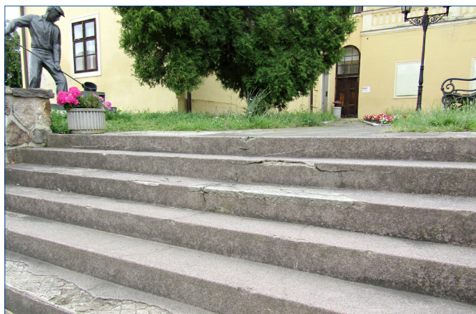
■ Oprava zámeckého schodiště začne letos v září. Foto: var
