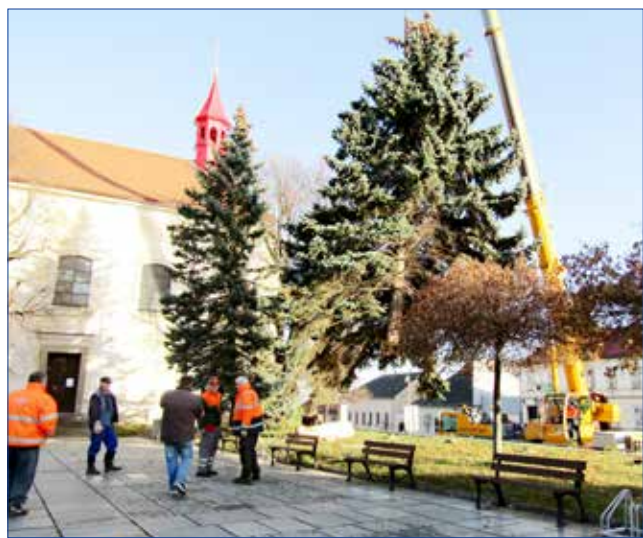
■ VÁNOČNÍ STROM. V pátek 20. listopadu byl na Palackého náměstí přivezen vánoční strom. Jeho instalaci zajistili pracovníci AVE Beroun a Technických služeb města Hořovice. Ze známých důvodů se v letošním roce neuskuteční slavnostní rozsvícení stromu. Vánoční atmosféru v adventním čase ale rozhodně navodí, rozzáří se každý den souběžně s veřejným osvětlením. Více fotografií najdete na Facebooku města. Foto: Radka Vaculíková
