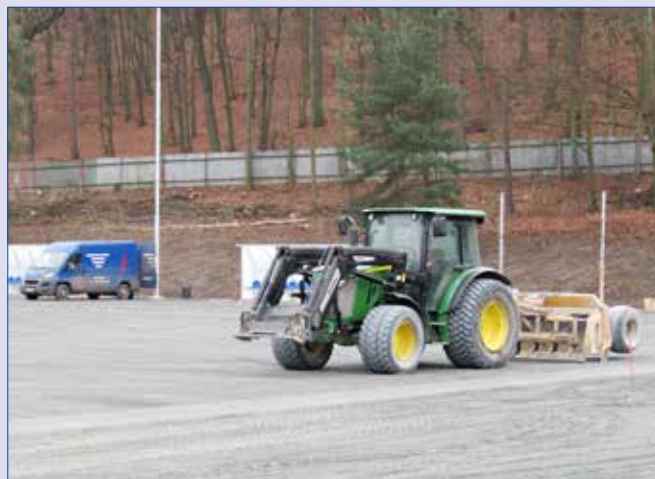
■ V prosinci se dokončovaly práce na novém hořovickém hřišti s umělou trávou. Foto: var
