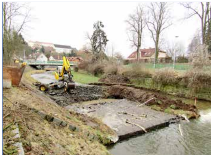
■ Český hydrometeorologický ústav provádí na Červeném potoku rekonstrukci stanice povrchových vod. Foto: Radka Vaculíková
