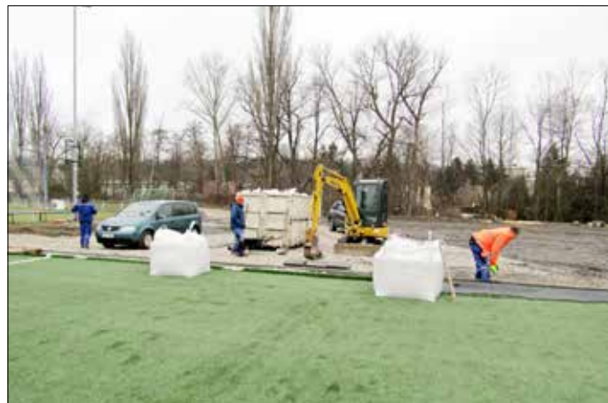
■ Nové hořovické hřiště s umělou trávou bylo zkolaudované loni v prosinci, v lednu a únoru se podle počasí odstraňovaly nedodělky. Foto: var
