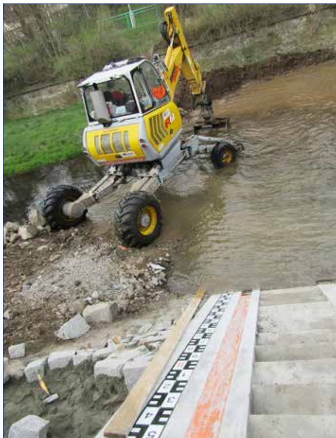
■ V rámci rekonstrukce byl vybudován nový měrný profil – práh, schody, vodočet a chránička. Vše je součástí vodoměrné stanice. 3x foto: var
