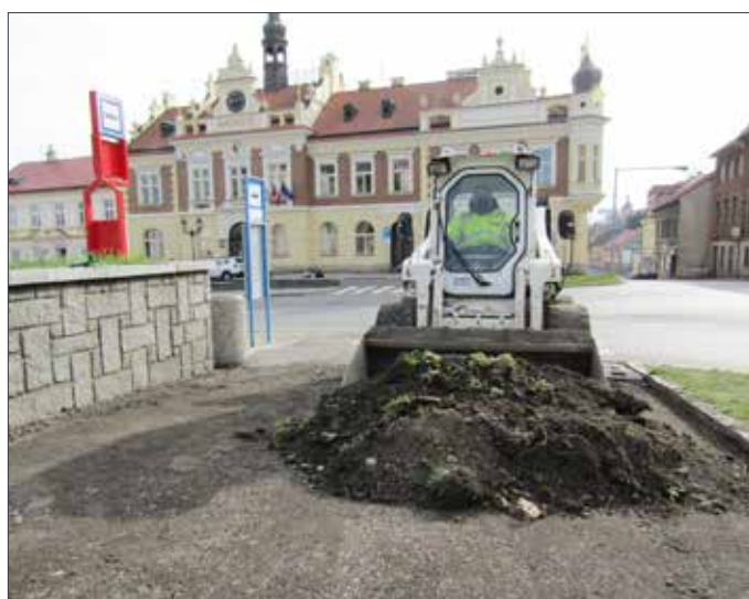
■ Oprava nejvíce poškozených asfaltových chodníků na Palackého náměstí se uskutečnila v dubnu. Foto: var
