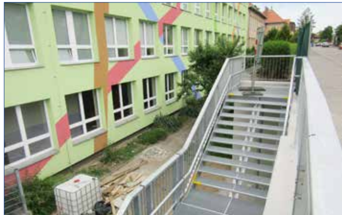
■ Rekonstrukce prvního ze dvou ramen venkovního schodiště 1. základní školy je dokončena. Úprava druhého ramene je naplánována na letní prázdniny.
