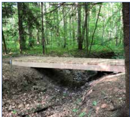
■ Jednou z rozmanitých prací Technických služeb byla také rekonstrukce lávky přes potok v Bažantnici. Prakticky novou lávku zhotovila letos na jaře pracovní četa pod vedením Antónína Bezděky.
