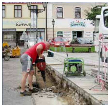
■ Technické služby města zajišťují řadu stavebních prací. Podílely se i na obnově schodiště na Palackého náměstí.
