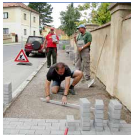
■ Oprava chodníku podél zámecké zdi.
