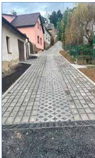
■ Ulice Malá po opravě
