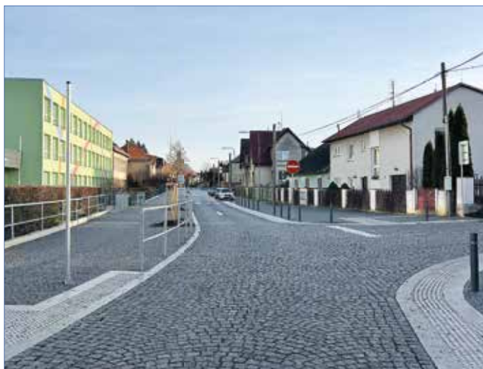
■ Zrekonstruovaná Komenského ulice
