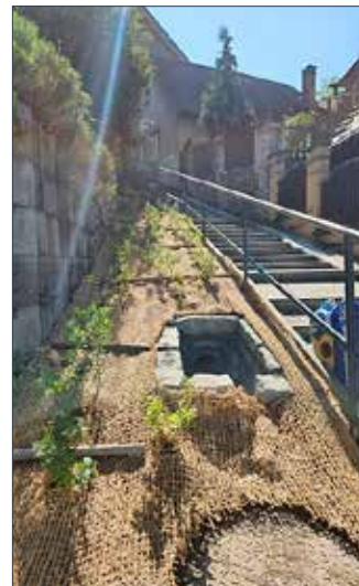
■ Žižkov - odvodnění schodů
