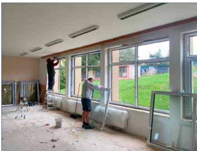
■ Rekonstrukce 4. pavilonu v MŠ Větrná.
