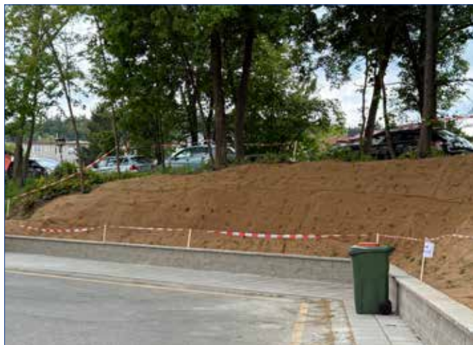
■ ...a po rekonstrukci
