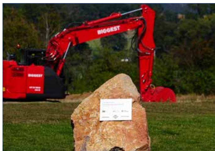
■ Zahájení stavby Východního obchvatu
