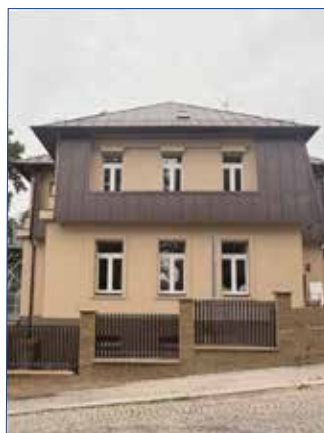
■ ...a po rekonstrukci
