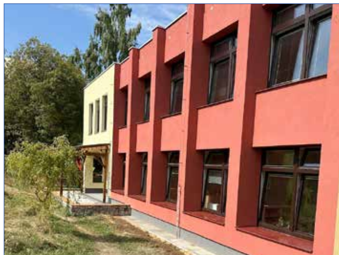
■ ...a po rekonstrukci
