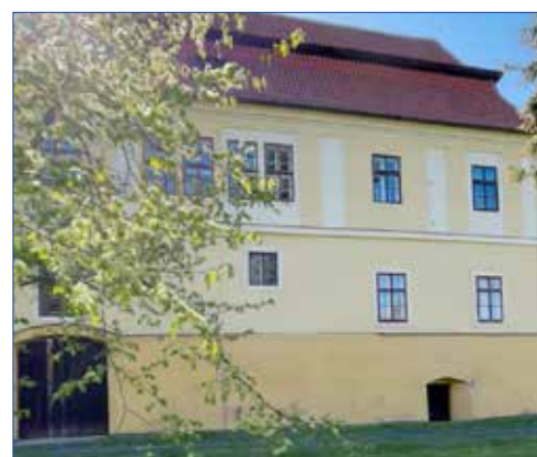
■ Starý zámek po rekonstrukci
