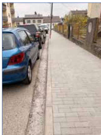
■ ...a po rekonstrukci
