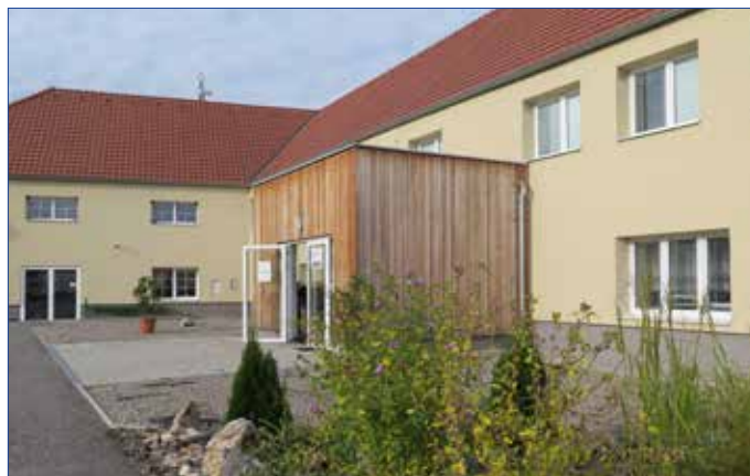
■ V Tlustici na půdě dřívějšího školního statku bylo vybudováno zcela nové učiliště a centrum odborného výcviku.
