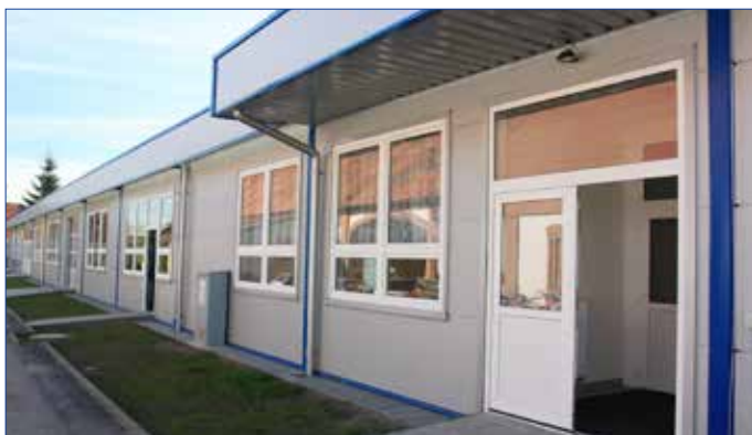
■ Nová dispozice vznikla novostavbou dílen a rekonstrukcí původních budov.
